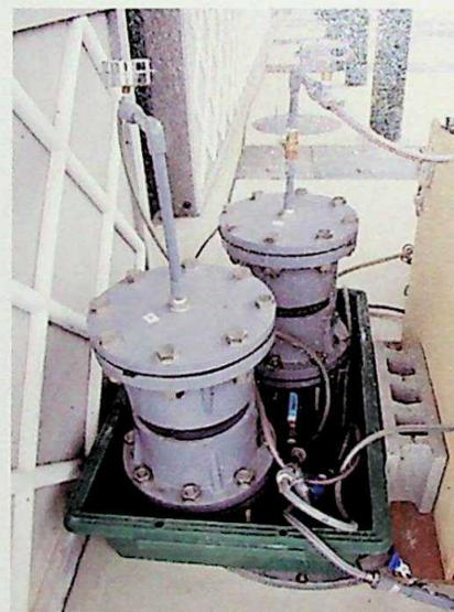
佐賀市諸富町の下水処理場での実用化実験の様子。HTとZeが入っているそれぞれのタンクに下水を通してリンとアンモニアを吸着させる。
